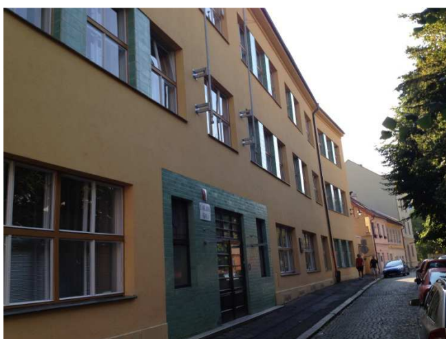
Základní škola v ul. Komenského
